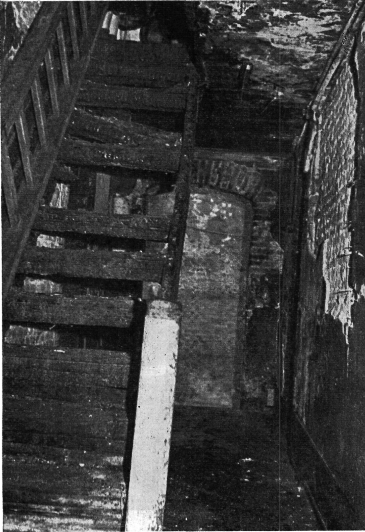
/ denne bygning ?ned kun een trappe af træ indebrændte en mand på 4. sal.
