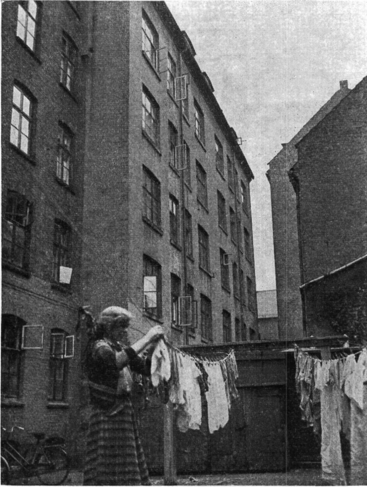
Baghusbebyggelse på Vesterbro fra den mellem Saxogade og Westend beliggende karre, som for tiden er taget op til sanering gennem kondemnering med påfølgende udhuling ved fjernelse af karreens baghuse og bevaring af forhusene.
