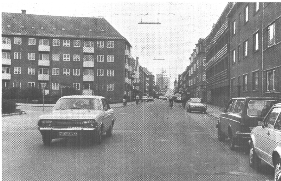
Figur 2. Strandbygade, Esbjerg, forretningsgade
